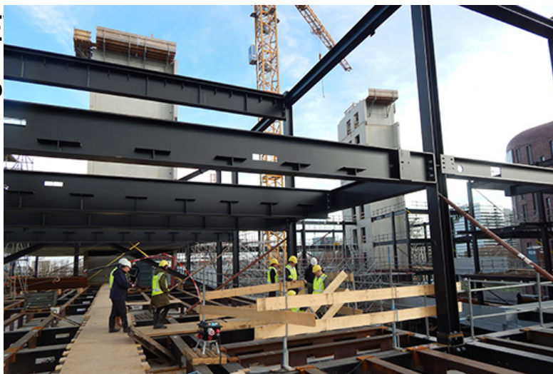
Het Nieuwe Universiteitsgebouw in aanbouw
